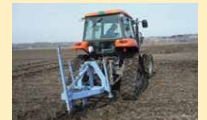
写真: カットドレーン施工状況
